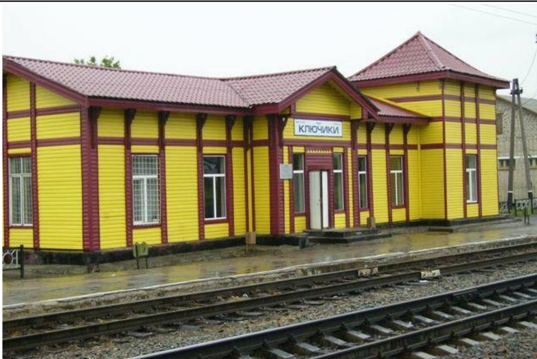
Рисунок 4. Железнодорожная станция "Ключики"
